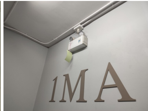
ระบบป้องกันอัคคีภัยและเตือนภัย ภายในห้องพักอาศัยและไฟฟ้าส่องสว่างฉุกเฉิน
